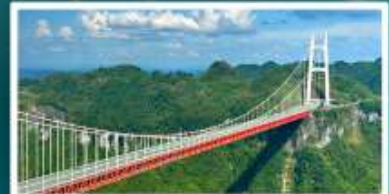
สะพานอ้ายจ้าย
