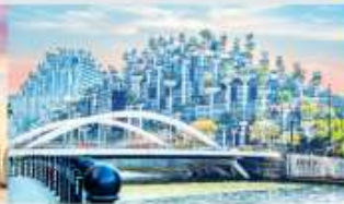
อาคารฟันทันไม้
